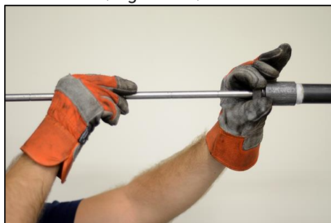
Figura 11 - Extracción de la varilla de inserción del puerto de acceso
